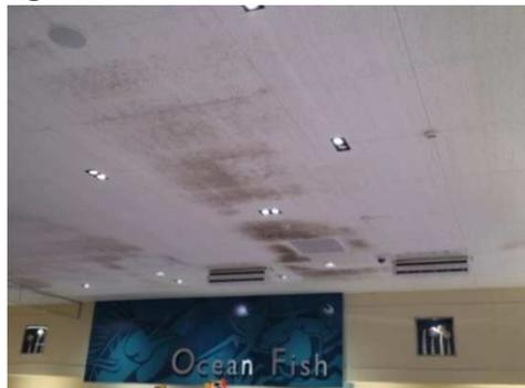
冷凍庫上部等に温度差による結露でカビが発生しています
