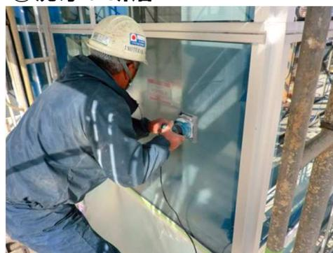
洗浄で汚れを落とし、専用研磨剤とサンダーで表面を磨きます
