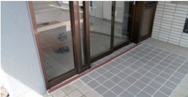
タイル目地の不陸調整 (SUSフラットバー取付) ※不陸が大きい
