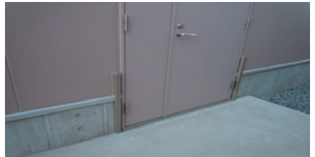
水切りの一部を切断し、サイド柱を取付。
