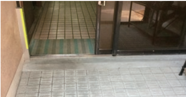
タイル目地の段差調整 (モルタル打設)
