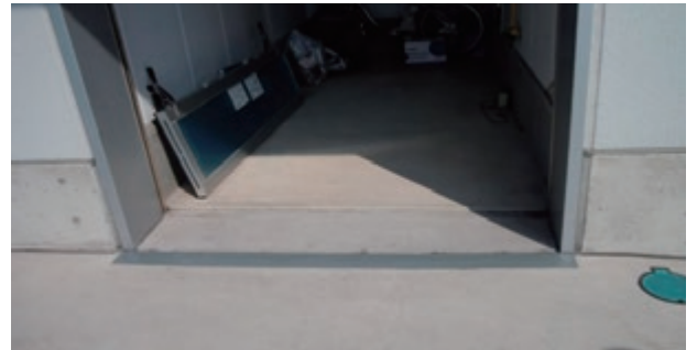
モルタル下地の不陸調整 (塗床と珪砂を混合。セルフレベルング材でも可。)
